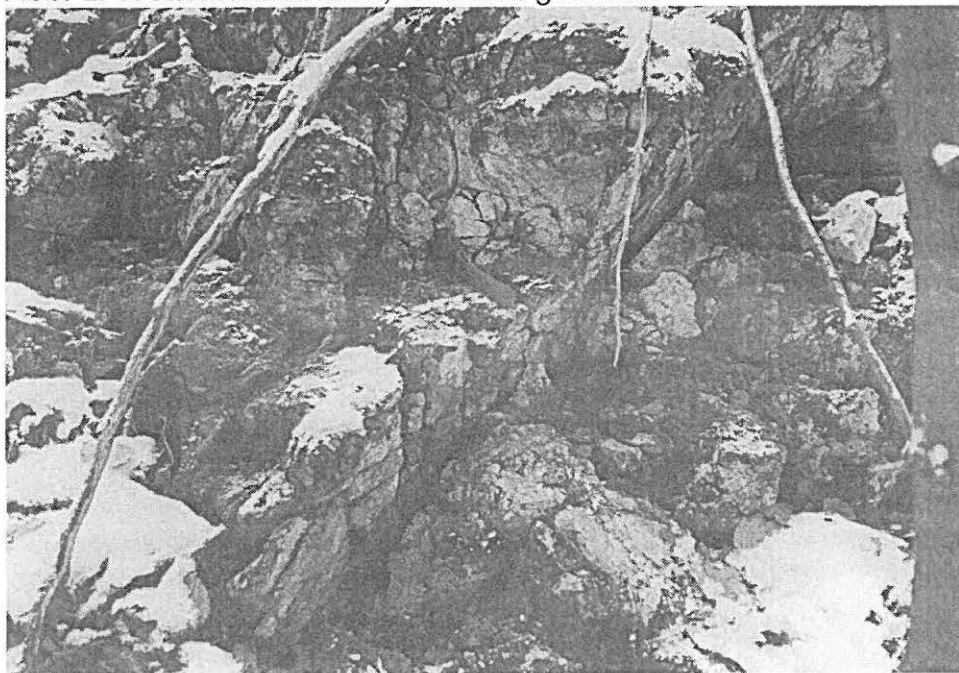
Abb. 2: Wettersteindolomit, teilweise geklüftet
